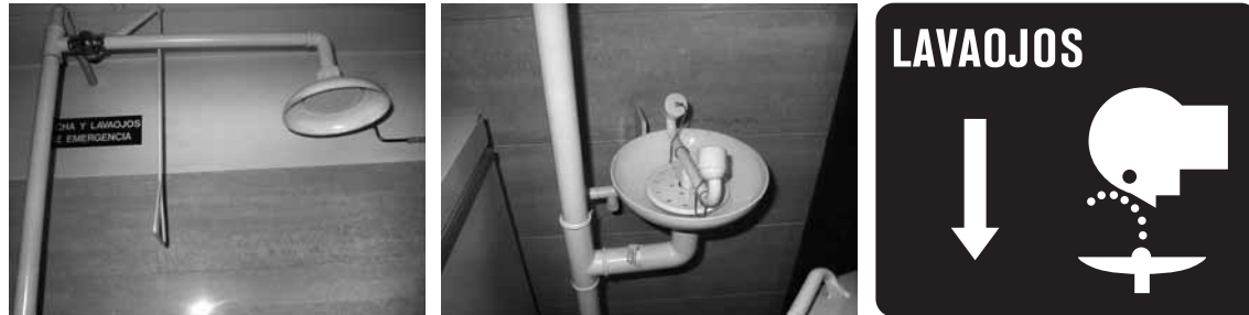
Figura 7. Representación de un lavaojos.
